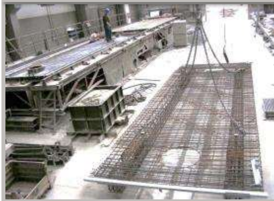
Güteüberwachte Produktion Handgefertigte Bewehrung
